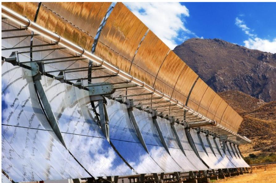
Figura 47: Concentração do calor em tubos. Fonte: PRALON (2011)
